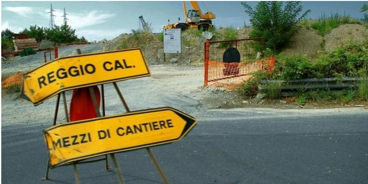
Image 8. Travaux en cours sur la route de Salerno Reggio Calabria
